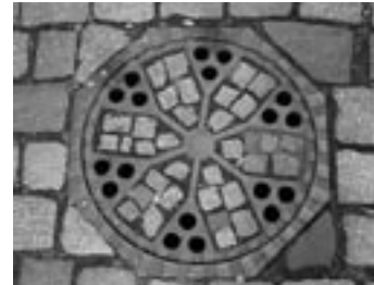
„Immerhin ein Versuch der Aufwertung“, meint Petra Friedrich zu diesem herkömmlichen Rosettenkanaldeckel mit Segmentfüllung aus Asphalt mitten im hochwertigen Kopfsteinpflaster des Weltkulturerbes.
