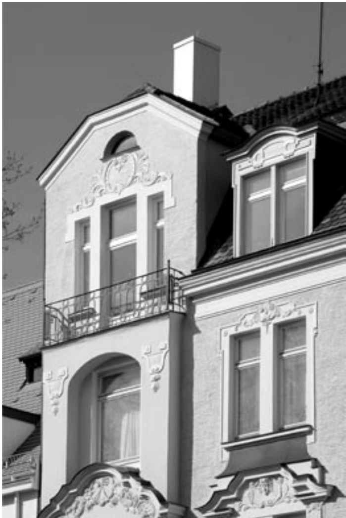
Auflage aus stadtgestalterischen Gründen: Die Mobilfunkanlage auf dem Haus Hainstraße 2 musste in einer eigens neu gebauten Schornsteinattrappe versteckt werden. Photo: Erich Weiß
