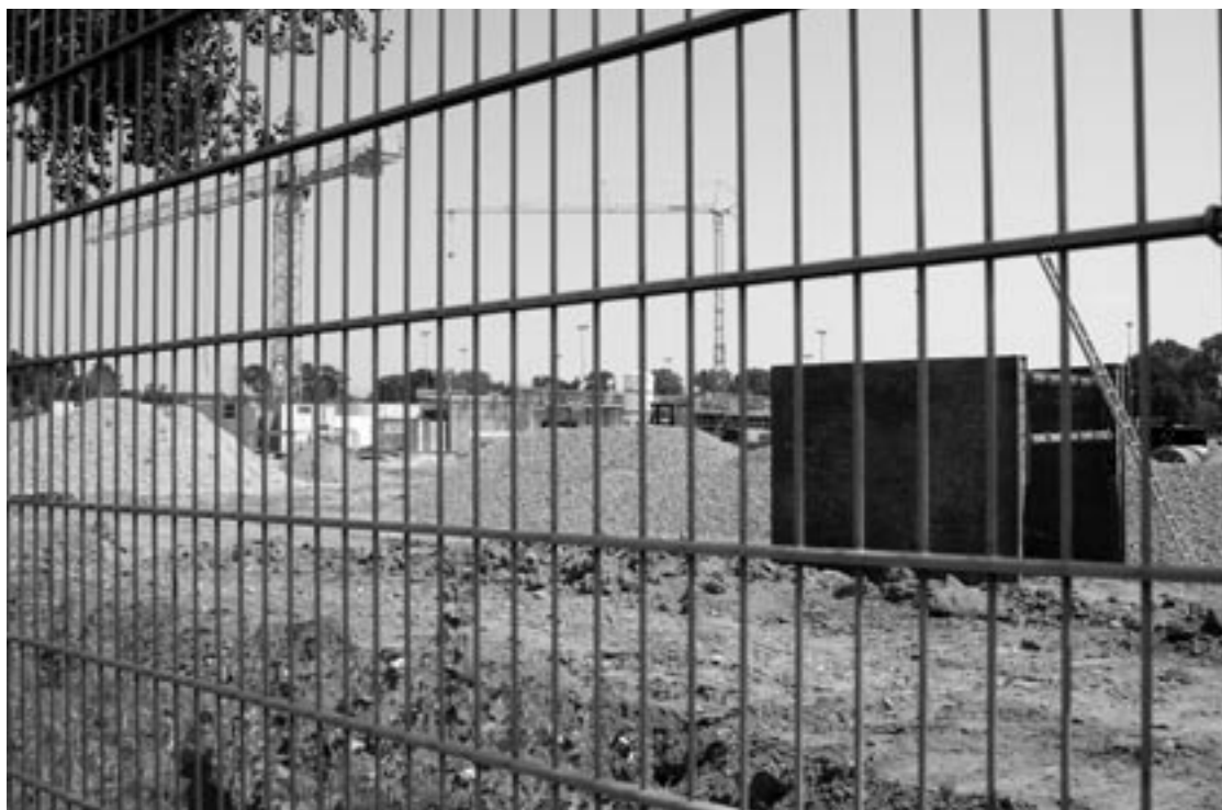
An der Ecke Berliner Ring – Zollnerstraße. Bautätigkeiten für ein neues Sportgelände Foto: Erich Weiß
