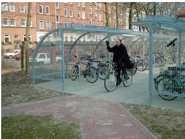
Abstellanlage mit Bügeln, Überdachung und Beleuchtung
