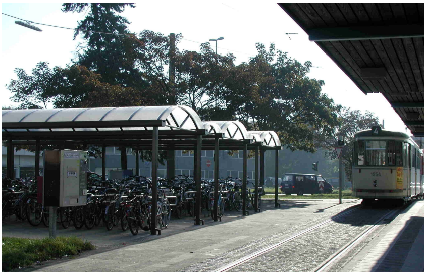
Abstellanlage an der Straßenbahn-Endhaltestelle Thon in Nürnberg
